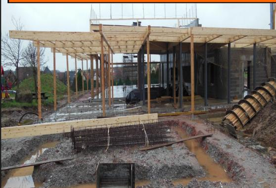
La superstructure en bois des auvents et du parvis sera couverte par des panneaux 'OSB'. L'étanchéité de la totalité de la couverture sera assurée par une membrane PVC de couleur verte.
