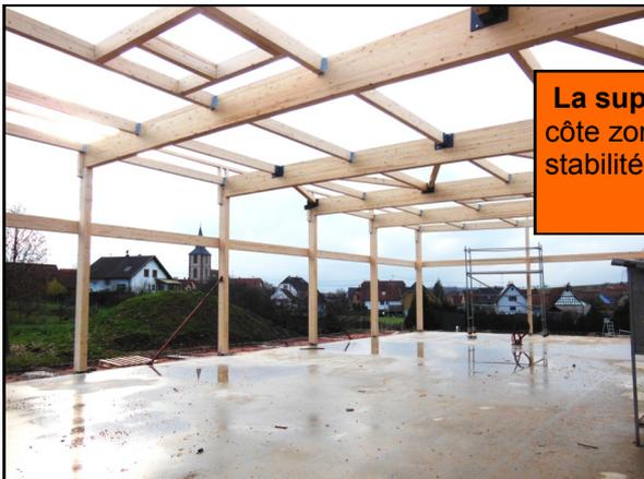
La charpente du toit des deux salles et de la zone technique est installée, Le chantier se poursuit avec la pose du patio de l'entrée principale et des auvents entourant le bâtiment.
