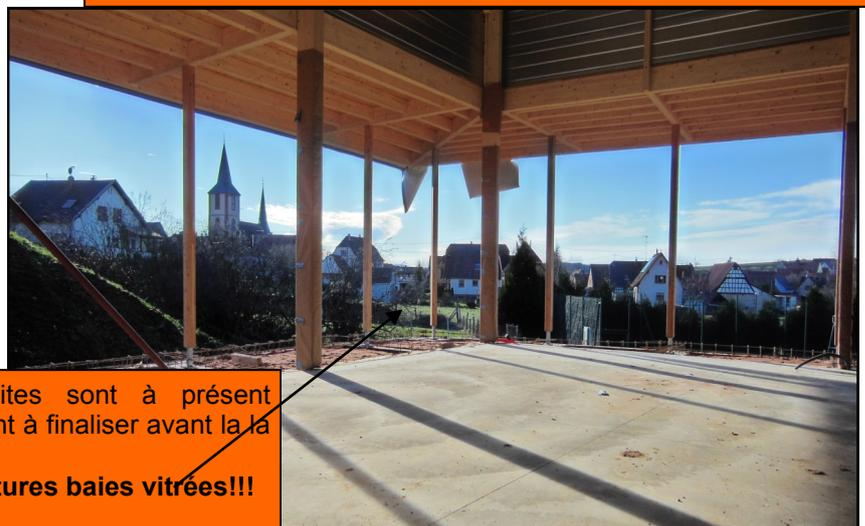
L'ossature et la charpente en bois construites sont à présent entièrement posées, quelques réglages restent à finaliser avant la pose des châssis vitrés en février 2015.
