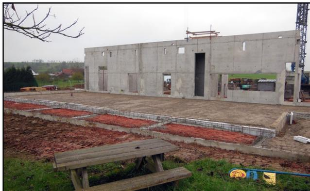
Sur une épaisse couche de matériaux isolant, la pose d'un treillis soudé assurera la rigidité de la dalle, et permet l'intégration des différentes gaines techniques côté cuisine et sanitaires.
