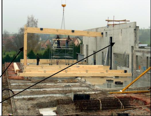
La superstructure est en partie en bois côté salle et en partie en béton côté zone technique faisant ainsi office de contreventement pour assurer la stabilité de la charpente dans le sens Nord-Sud.
