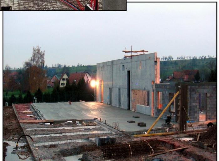
Le coulage du dallage en béton a été suivi de la construction des derniers murs maçonnés dans la zone technique. La fabrication des coursives et du parvis sera réalisée au début du printemps 2015 par l'entreprise **Sotravest**.
